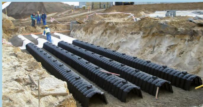
Sicker-Tunnel und Sicker-Tunnel Twin können auch kombiniert werden.
