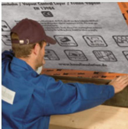
Für die Optimierung der Wärmedämmung ist die Knauf Insulation Dampfbremse LDS FlexPlus mit den entsprechenden Klebändern und Dichtkleber exakt zu verkleben, um Wärmeverluste und späteren Schäden an der Bausubstanz vorzubeugen.
