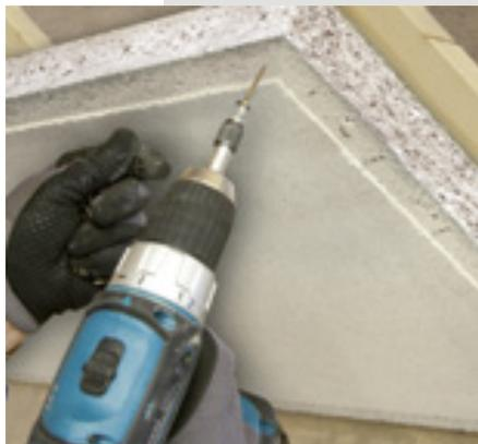
Zur Bepankung wird die spachtelfertige Holzwolle-Dämmplatte Heraklith BM-W einfach auf die Tragkonstruktion geschraubt und in den Fugen mit Heraklith BM-Kleber verklebt.
