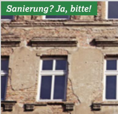
Schmutzablagerungen, Moos- und Algenbildung: mit einem Hochdruckreiniger rasch entfernbar. Wasserflecken: Nachdem die Ursache eruiert wurde, können die Stellen mit einem Feuchtblocker bearbeitet werden. Kleinere Risse: mit einer Spachtel aufkratzen, mit einem Rissfüller verschließen. Größere Risse: unsere Fachberater wissen Rat!
