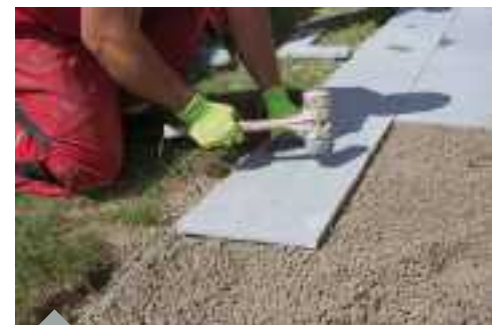
Pflastern in gebundener Bauweise
