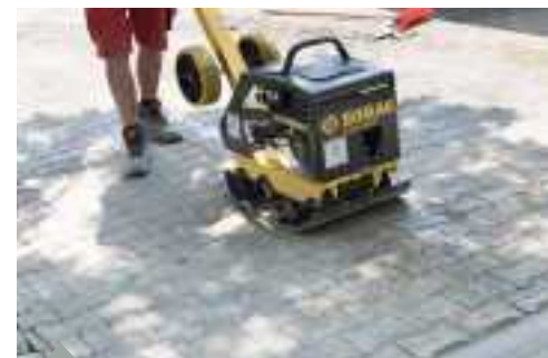
Abrütteln in ungebundener Bauweise
