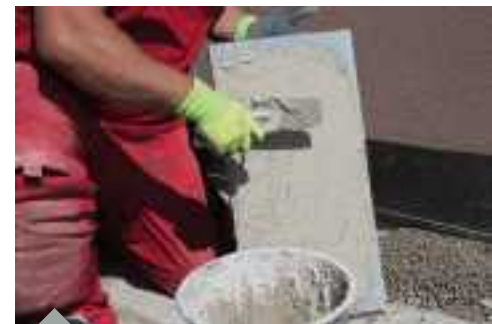
Verkleben in gebundener Bauweise
