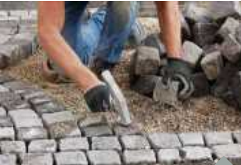
Pflastern in ungebundener Bauweise
