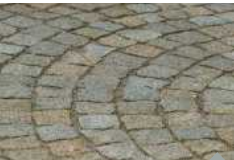
Verfugung in ungebundener Bauweise
