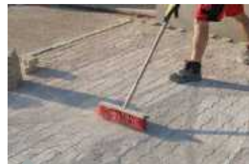
Verfugen in ungebundener Bauweise
