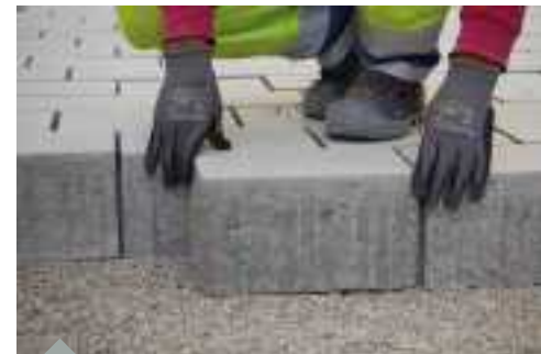
Verlegen in ungebundener Bauweise
