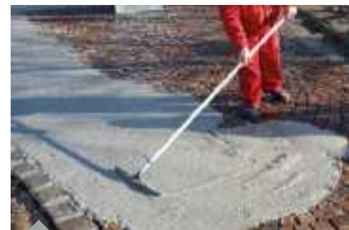
Verfugen in gebundener Bauweise
