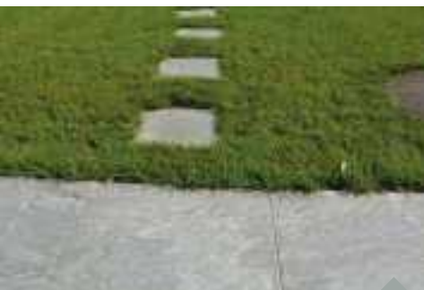
Abschluss Traufe in gebundener Bauweise
