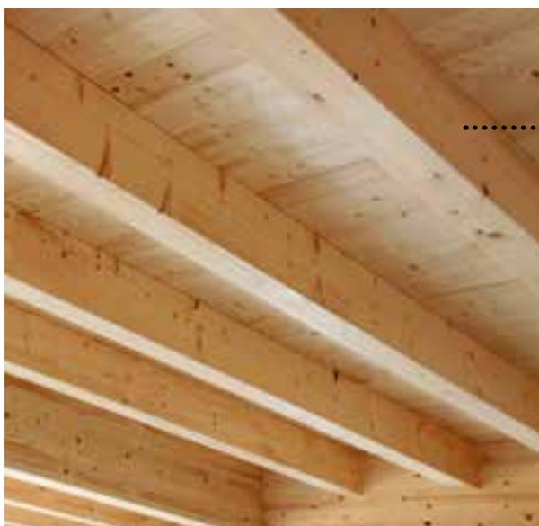
Beim Holzleichtbau wird unter den Fußböden oft Sand aufgeschüttet – so werden die Decken schwerer und bieten besseren Luftschallschutz. Außerdem liegt unter dem Fußboden häufig ein Trockenestrich. In dem Fall wird auf einer dünnen Schicht Mineralwolle eine Unterkonstruktion angebracht, die als Unterlage für den Fußboden dient.
