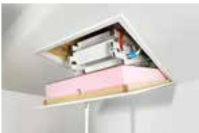
*16 cm Wärmedämmung im Unterdeckel*
