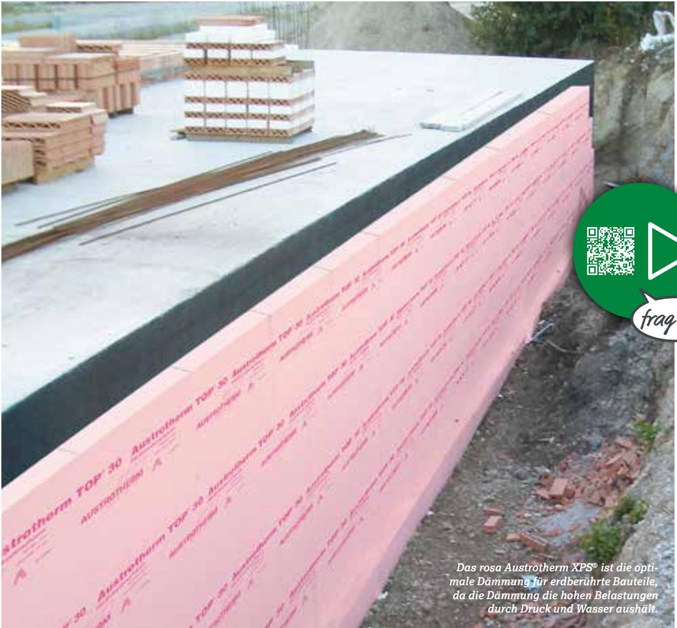
Das rosa Austrotherm XPS® ist die optimale Dämmung für erdberührte Bauteile, da die Dämmung die hohen Belastungen durch Druck und Wasser aushält.
