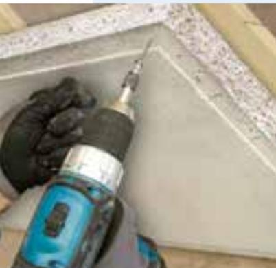
Zur Beplankung wird die spachtelfertige Holzwolle-Dämmplatte Heraklith BM-W einfach auf die Tragkonstruktion geschraubt und in den Fugen mit Heraklith BM-Kleber verklebt.
