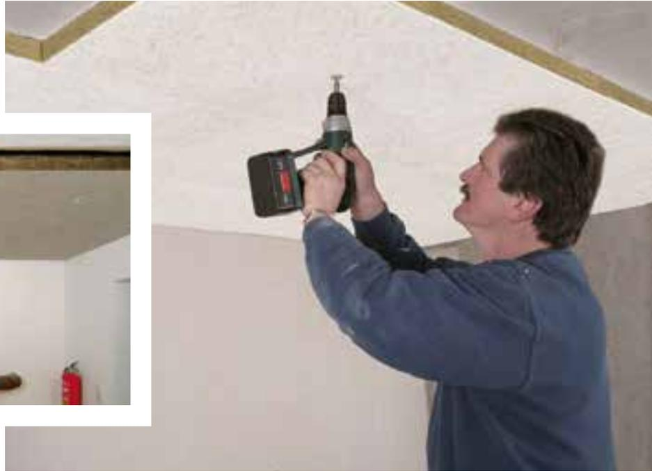
Meist reichen wenige Zentimeter Dämmstoff aus, um Wärmeverluste hin zu nicht beheizten Kellerräumen zu verhindern. Knauf Insulation Dämmplatten für die Kellerdecke sind obendrein rasch montiert und unangenehme Fußbodenkälte gehört somit der Vergangenheit an. Grundsätzlich muss nur geklärt werden, ob die Kellerräume intensiv genutzt werden und ob die Dämmung auch optisch höheren Ansprüchen genügen muss.
