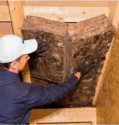
Die flexible und gleichzeitig kompakte Mineralwolle-Dämmplatte MINERAL PLUS lässt sich einfach zwischen die Sparren klemmen. Auch Reststücke können problemlos mit eingebaut werden.
