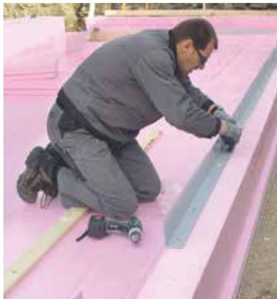
**Austrotherm Fundamentplatten-Dämmsystem:** Die Fundamentplatte wird von unten gedämmt.
