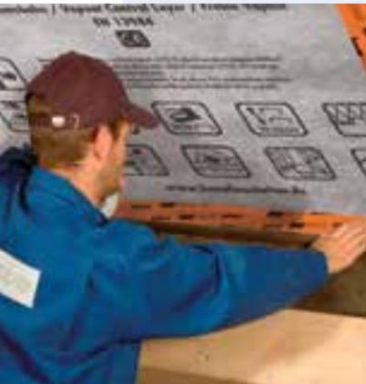
Für die Optimierung der Wärmedämmung ist die Knauf Insulation Dampfbremshahn LDS FlexPlus mit den entsprechenden Klebebändern und Dichtkleber exakt zu verkleben, um Wärmeverluste und späteren Schäden an der Bausubstanz vorzubeugen.
