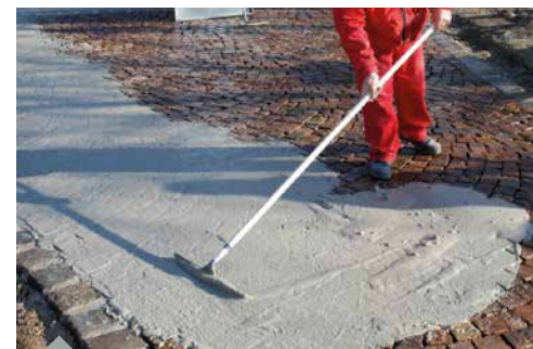
Verfugen in gebundener Bauweise
