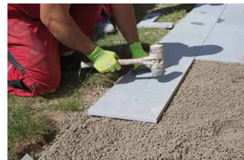
Pflastern in gebundener Bauweise
