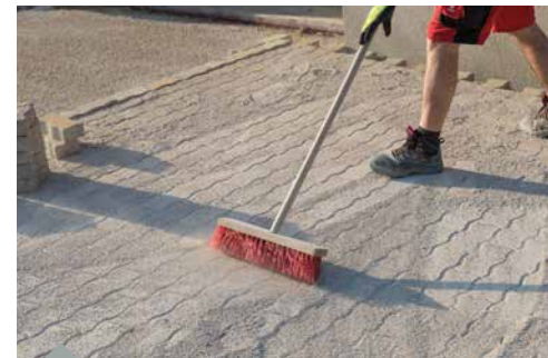
Verfugen in ungebundener Bauweise
