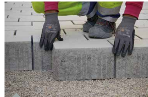
Verlegen in ungebundener Bauweise
