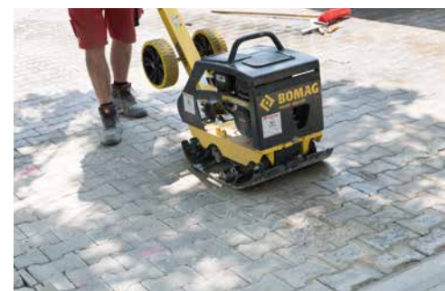
Abrütteln in ungebundener Bauweise
