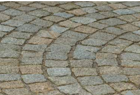
Verfugung in ungebundener Bauweise
