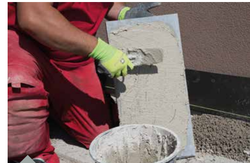
Verkleben in gebundener Bauweise
